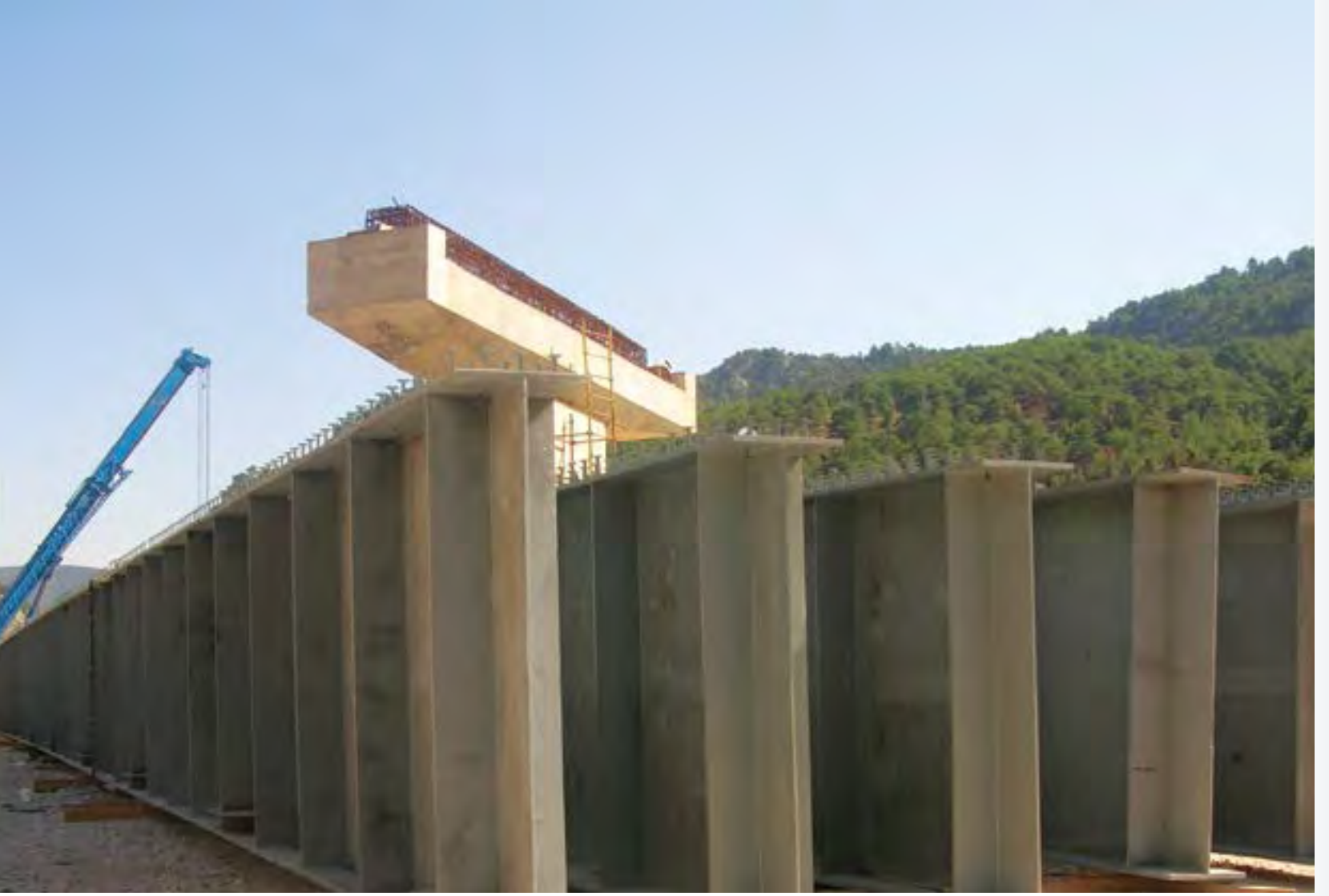
LİMAK İNŞAAT Otoyol Çelik Köprü 1200 Ton BİLECİK
