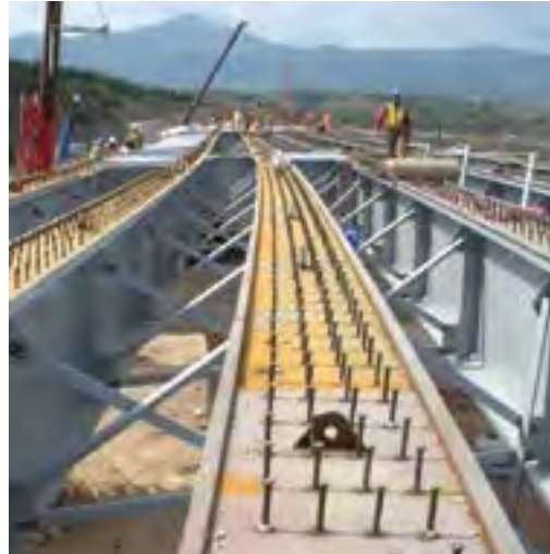
LİMAK-KOLİN Mekece Autobahn Viadukt 2500 Tonnen BİLECİK
