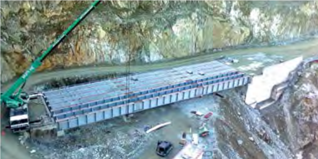
SİSTEM BAU Artvin - Erzurum Autobahn Brücke 3500 Tonnen ARTVİN
